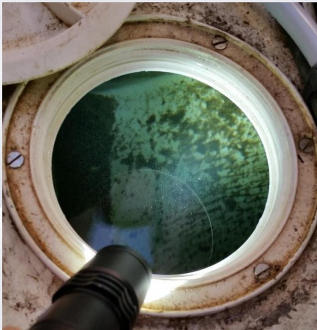
Las biopelículas se forman en la superficie de los depósitos de agua de barcos, trenes, casas móviles, etc. al cabo de poco tiempo.
