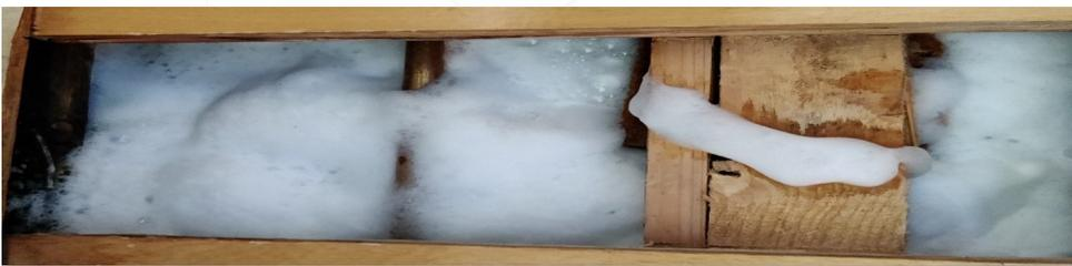
Biozider Schaum aus SFS und Sanosil S015 in einem Unterlagsboden nach Wasserschaden mit anschliessendem Schimmelpilzbefall.
