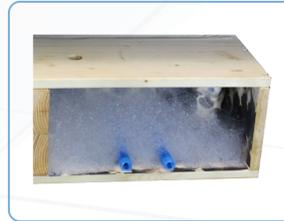
Schnittmodell einer Desinfektionsschaumanwendung / Einpressen des Schaumes in eine Unterbodenkonstruktion nach Wasserschaden
