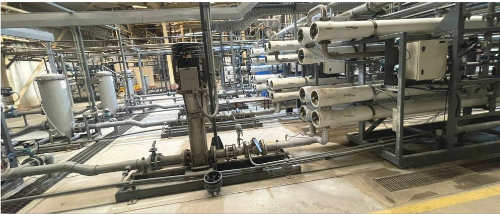
Industrielle Wasseraufbereitungsanlage mit Vorfiltern (links) und Membranfiltern (rechts)
